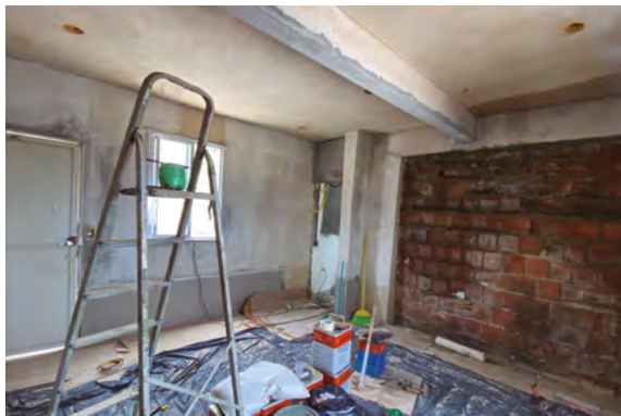
Escritório da Rede NAMI durante a reforma NAMI office during renovation.
